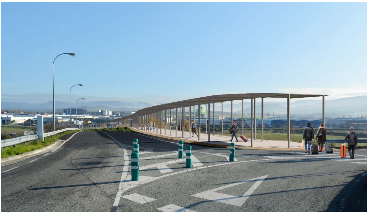
Vista de la llegada de la conexión peatonal al recinto del aeropuerto
